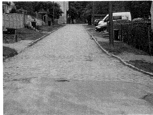
Zdjęcie nr 14. Stan techniczny pobocza w Górcie Sobockiej.
