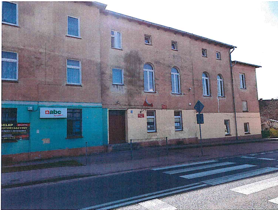
Budynek w którym znajduje się świetlica wiejska
