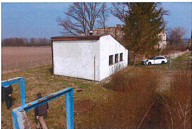
Budynek SUW ze zbiornika zapasowo – wyrównawczego
